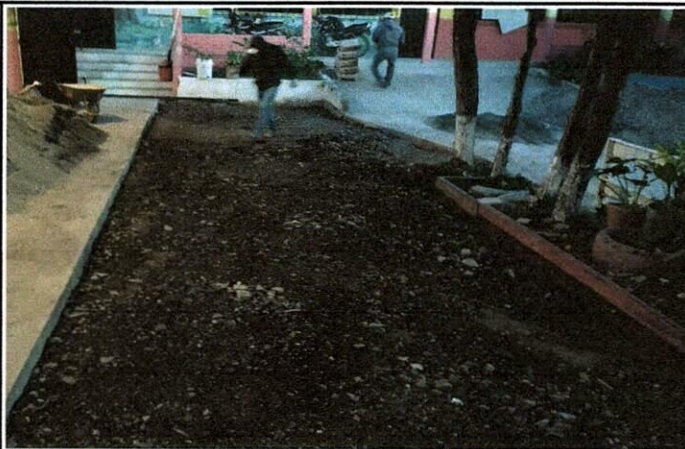
Foto 3: LOSA DE PATIO
