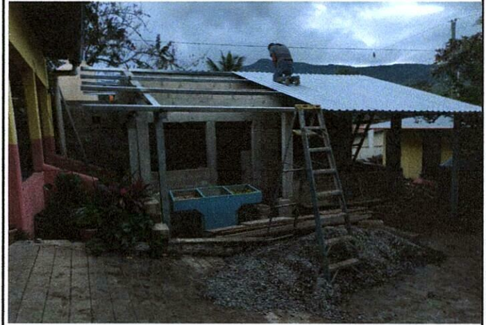
Foto 2: MEJORAMIENTO DEL AREA DE COCINA
