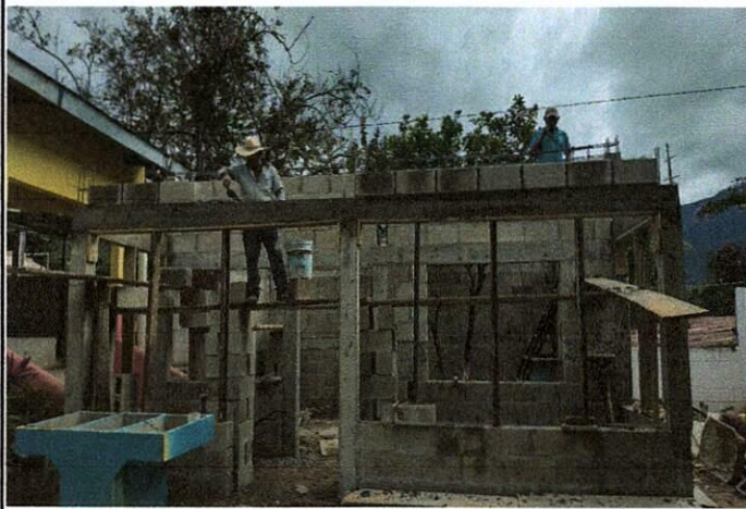
Foto1: MEJORAMIENTO DEL AREA DE COCINA
